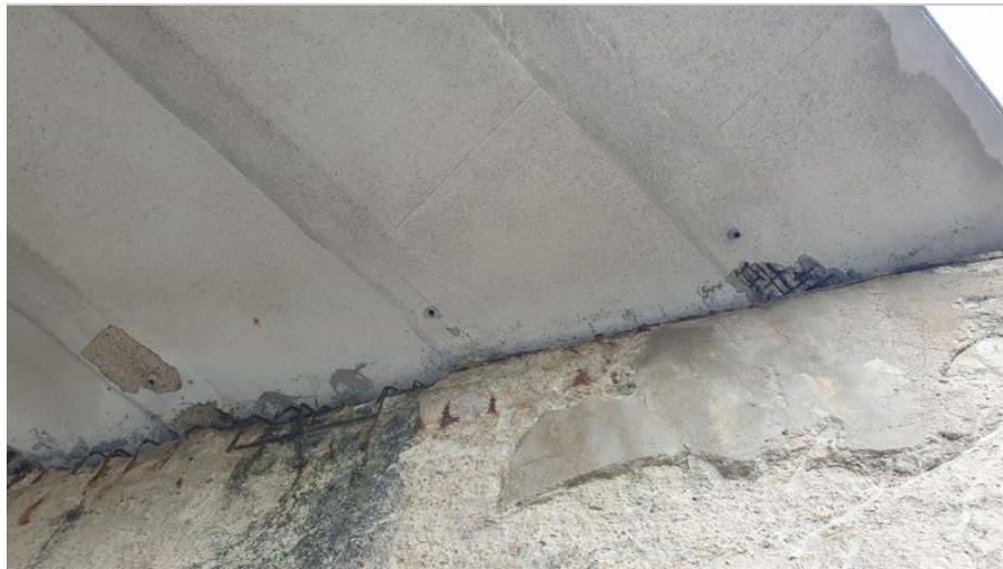
16-Zatékání a koroze výztuže dobetonávky nosníků v místě uložení.jpg
