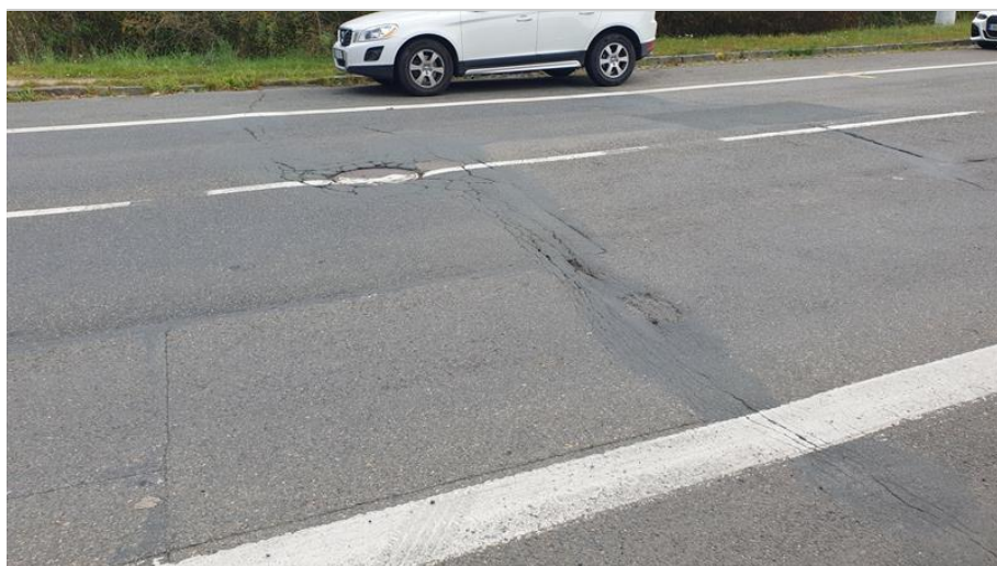
35-Trhliny ve vozovce za mostem.jpg
