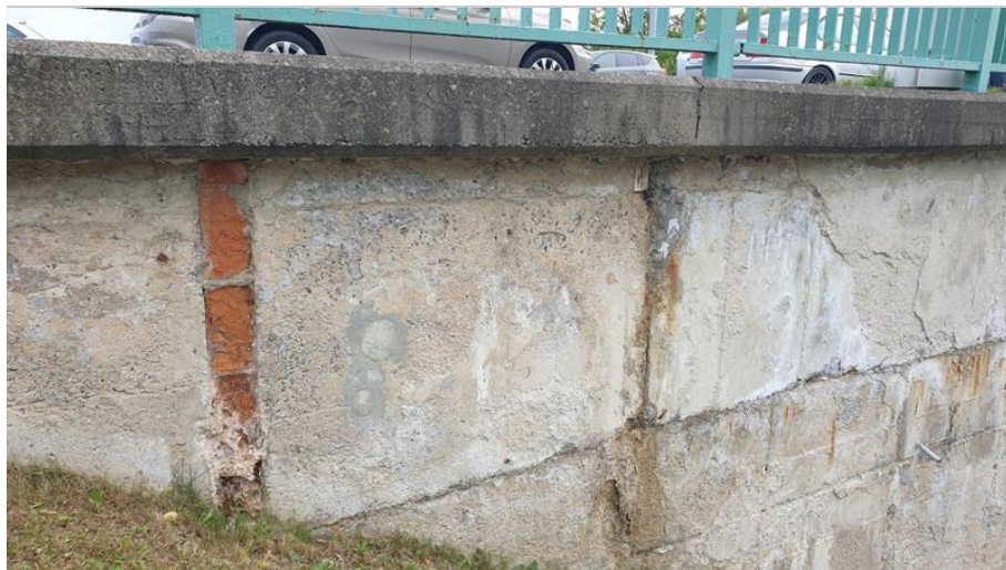
22-Degradace povrchu křídel.jpg
