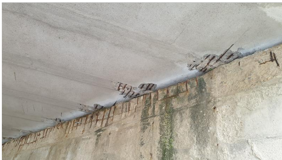
14-Degradace povrchu křídla u OP2 vlevo.jpg
