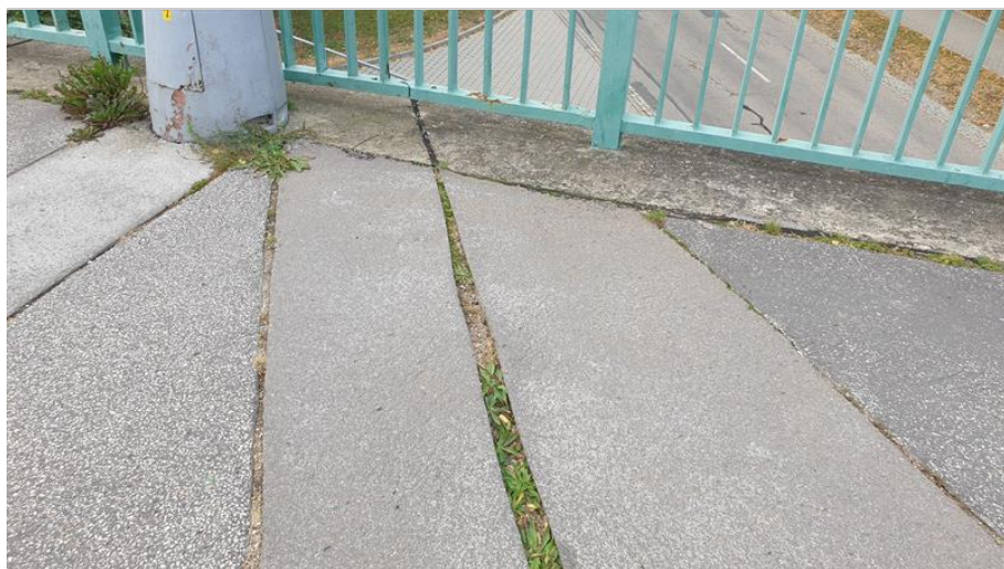
25-Chodník na mostě vpravo záplaty spáry bez zálivek.jpg
