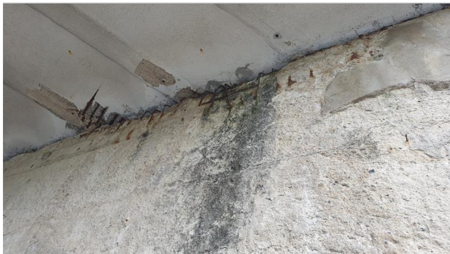
07-Degradace betonu koroze výztuže.jpg
