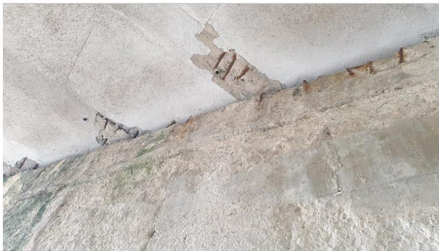
17-Zatékání a koroze výztuže dobetonávky nosníků v místě uložení.jpg
