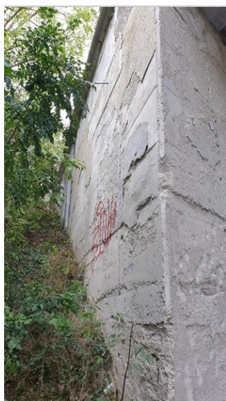
14-Degradace povrchu křídla u OP2 vlevo.jpg
