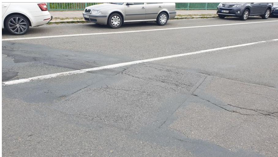
30-Četné trhliny výpravy zálivky nad OP1.jpg
