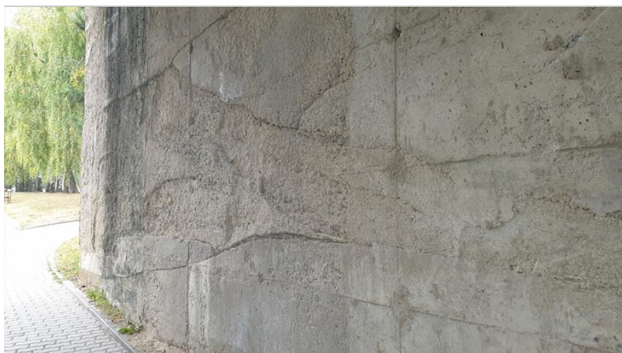
08-Různá kvalita betonu ve vrstvách OP1.jpg
