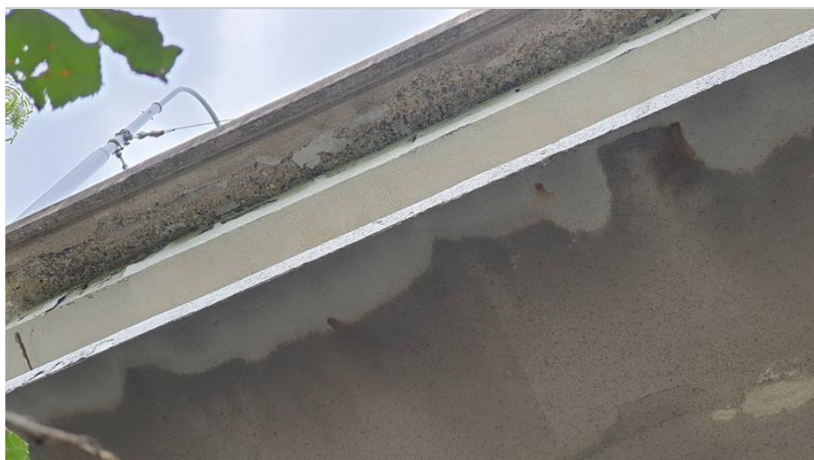
15-Stopy po zatékání na podhledu NK.jpg
