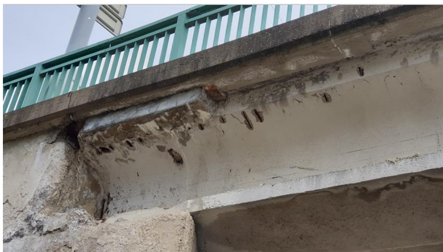
20-Pravá strana krajní nosník zatékání na konci NK.jpg
