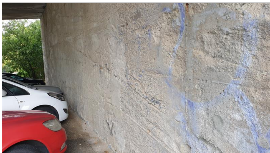
12-Degradace betonu OP2.jpg
