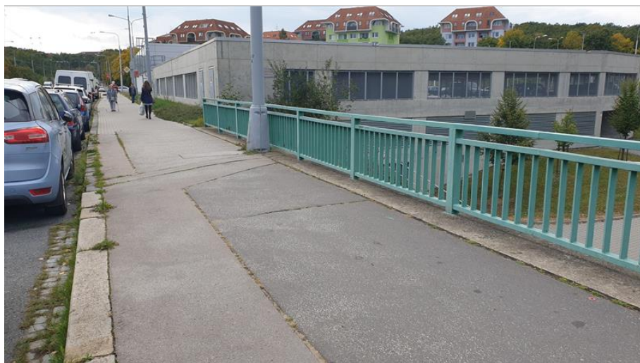
24-Chodník na mostě vpravo záplaty spáry bez zálivek.jpg
