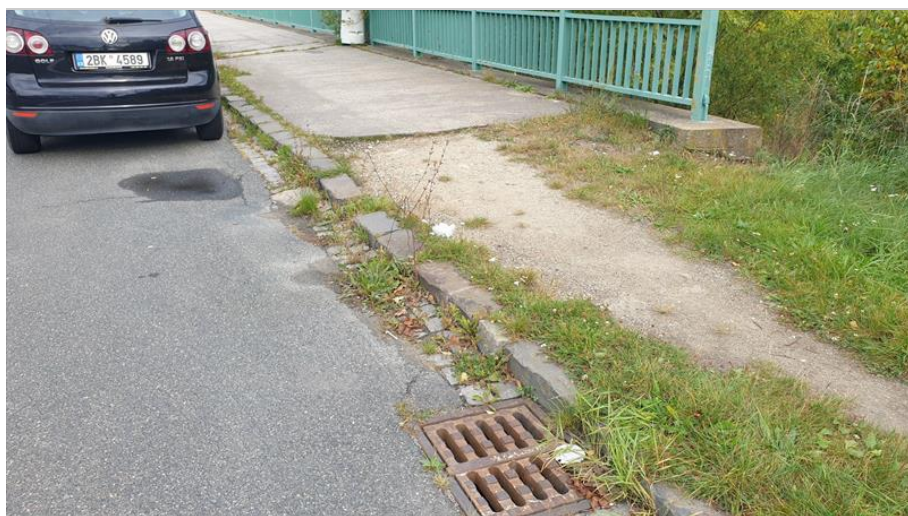
26-Na levý chodník nenavazuje zamostem zpevněný povrch.jpg
